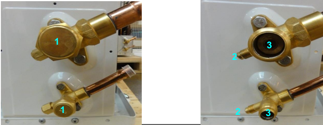
Figure 26 : Vannes de service pour la charge en fluide
