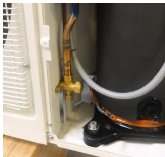
Figure 27 : Raccord pour la maintenance, situé sur la ligne liquide
