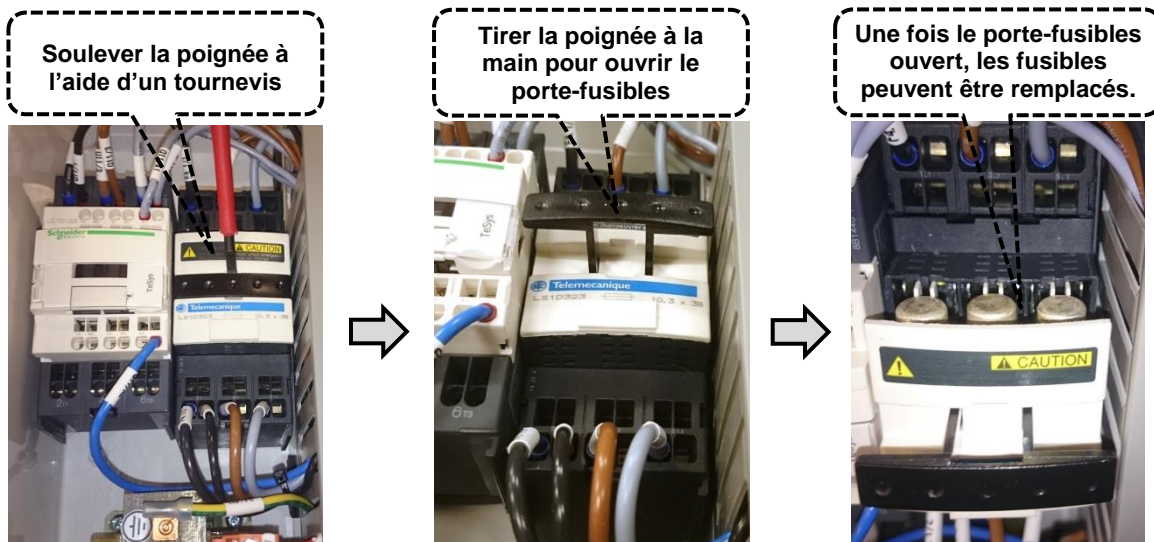
Figure 23 : Remplacement des fusibles
